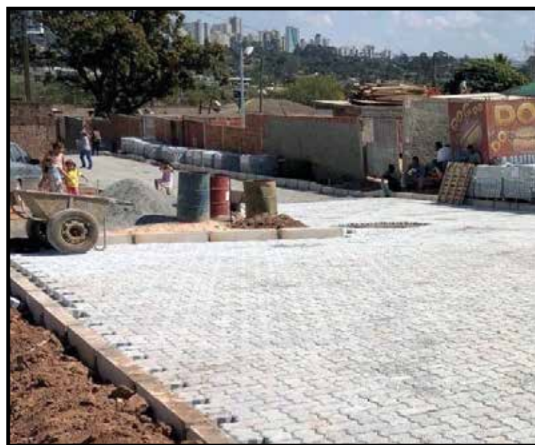
Pavimentação está em fase final
