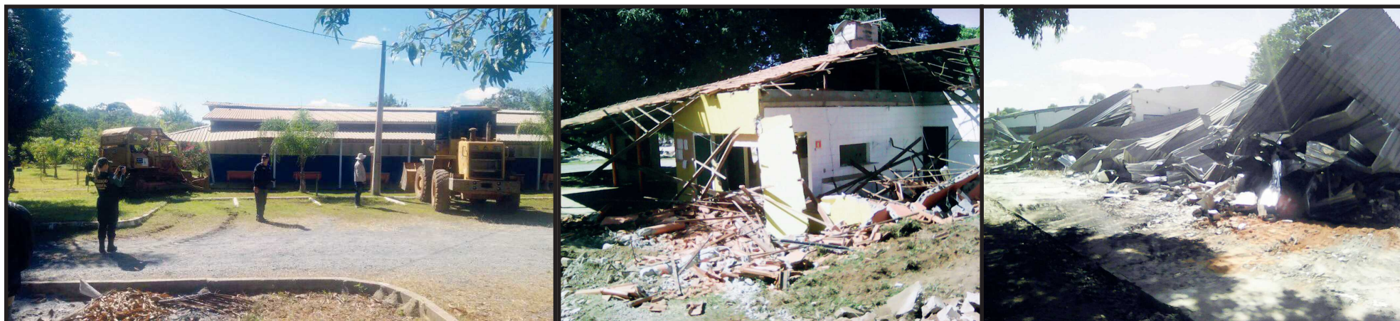
Galpão onde eram realizadas as exposições veio ao chão em poucos minutos. Só ficaram em pé duas casas ocupadas por funcionários
