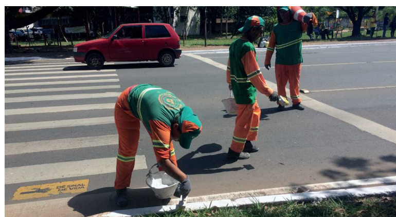
Conservação incluiu recuperação e pintura de meios-fios
