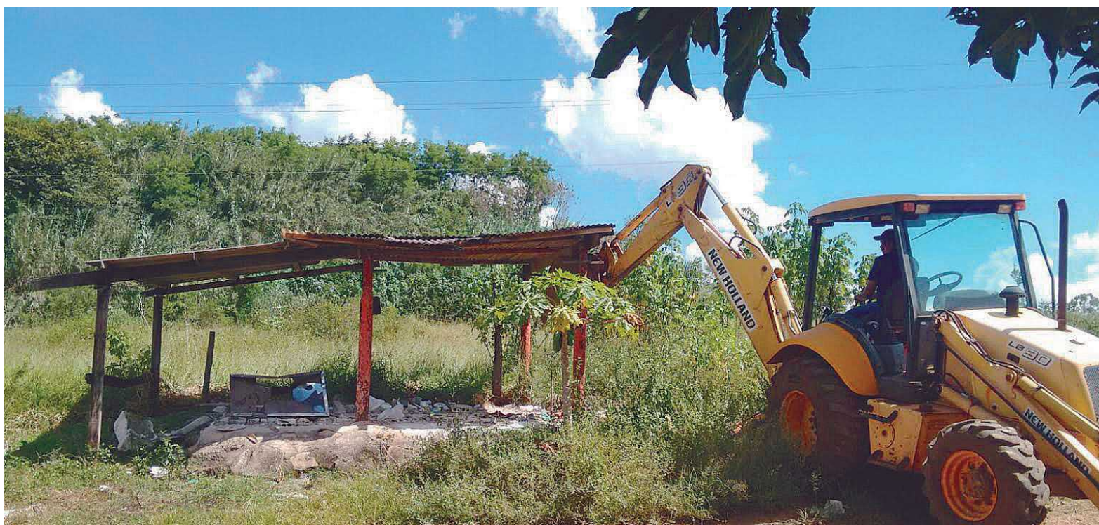
Todas as benfeitorias das chácaras serão demolidas
