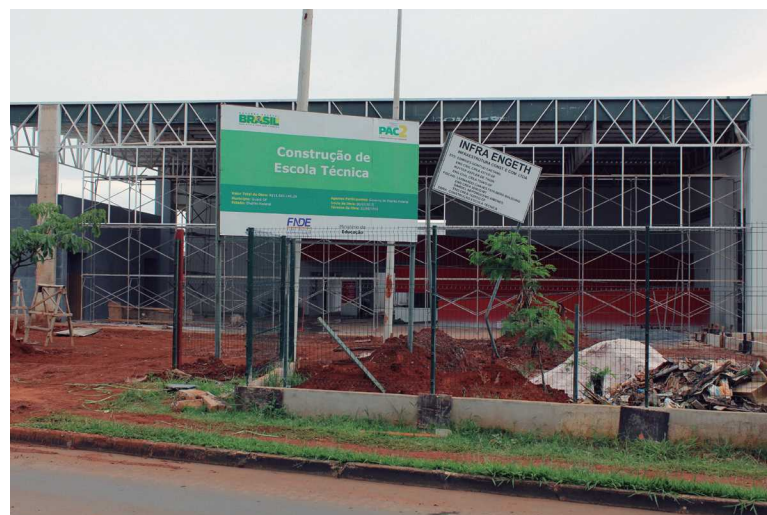
A obra física entra na fase final e será entregue no início de 2017
