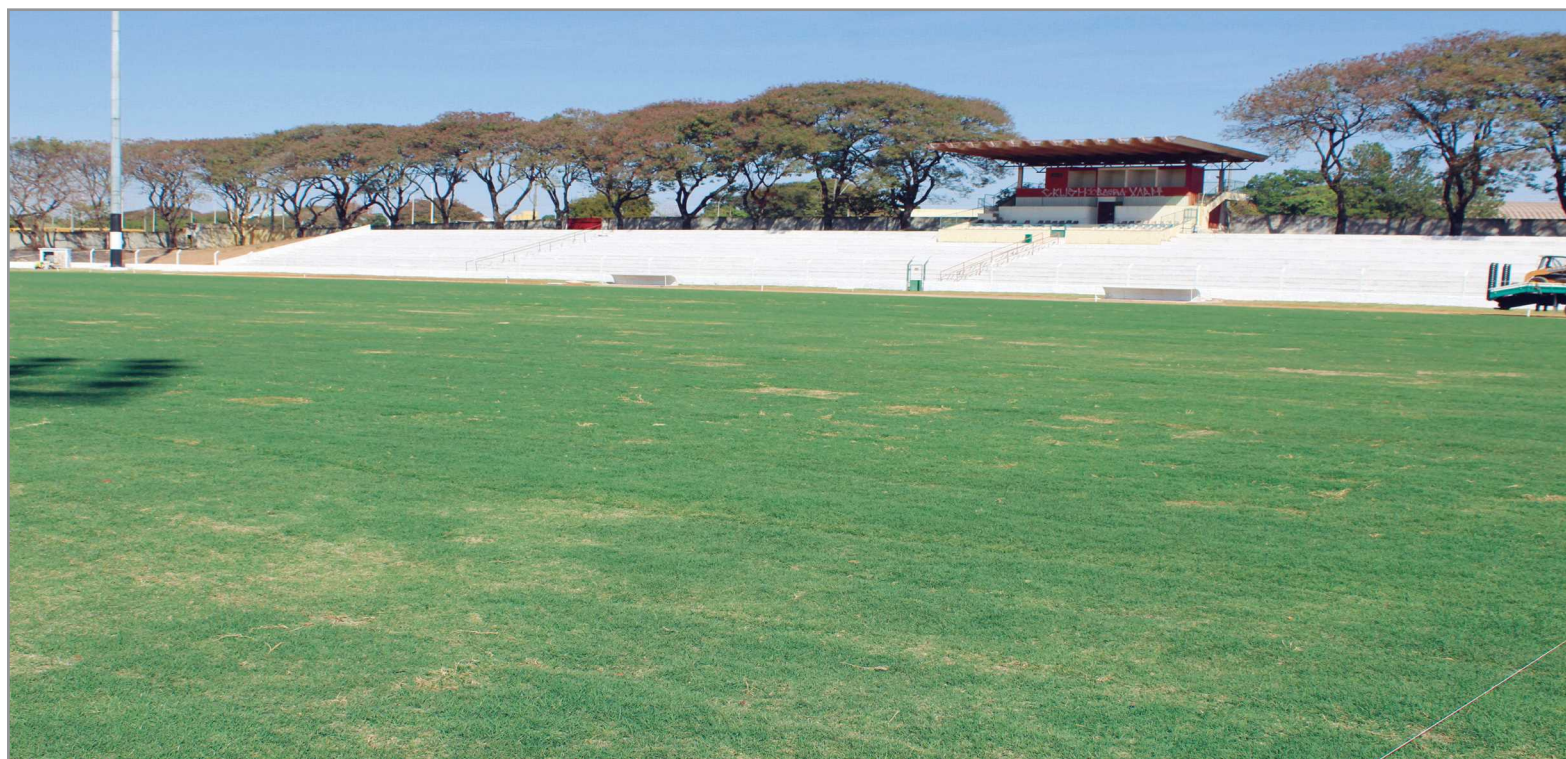
Gramado foi plantado em junho, mas não está recebendo manutenção depois que a construtora deixou a obra
