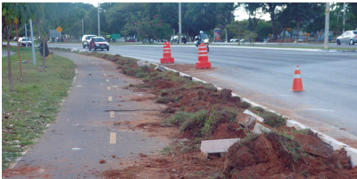
Altura padrão dos meios-fios deve ser de 15cm sobre o asfalto
