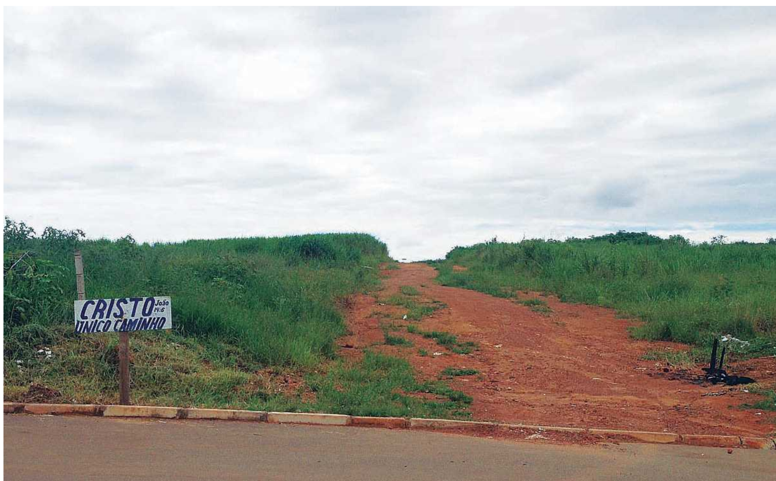
Parte da área destinada às cooperativas não possui infraestrutura, que é exigida pelo programa Minha Casa, Minha Vida
