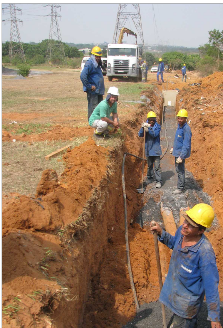
Nova rede já está sendo adaptada para receber a nova via e o Centro Metropolitano
