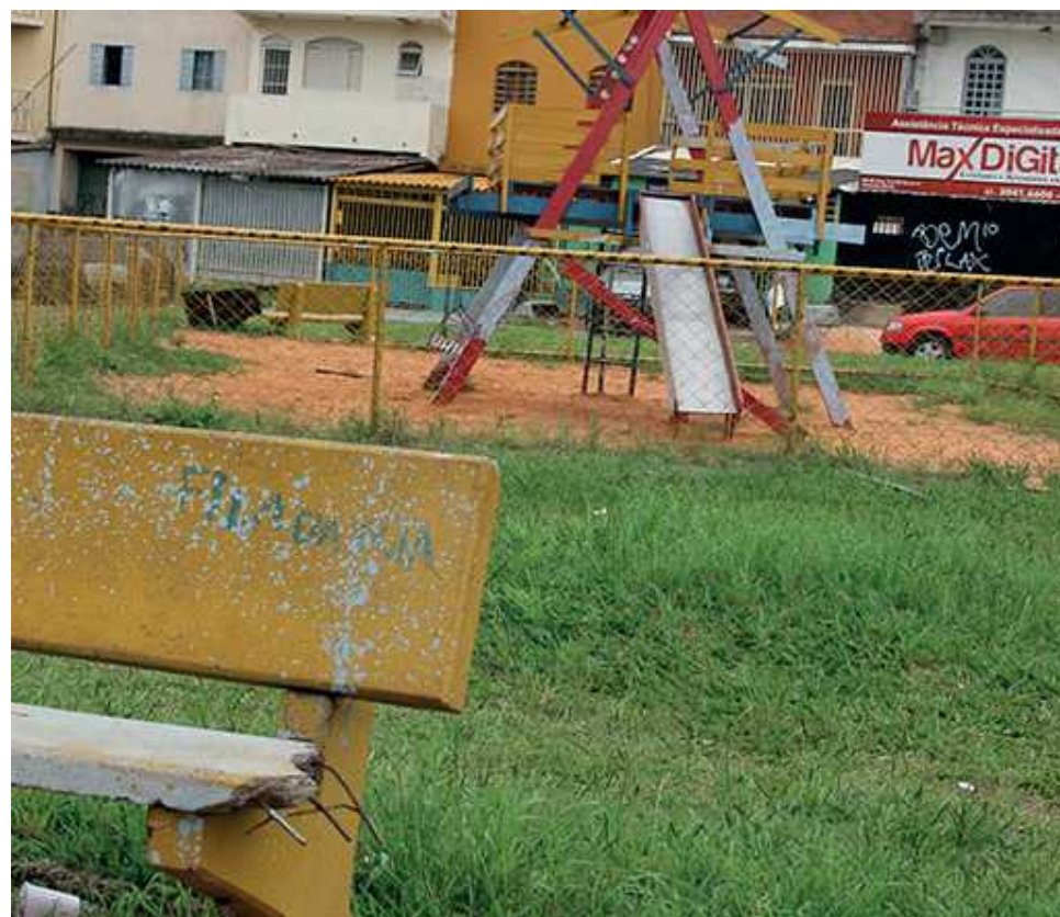
Praça Itajubá, na QE 40: equipamentos quebrados e sujeira
