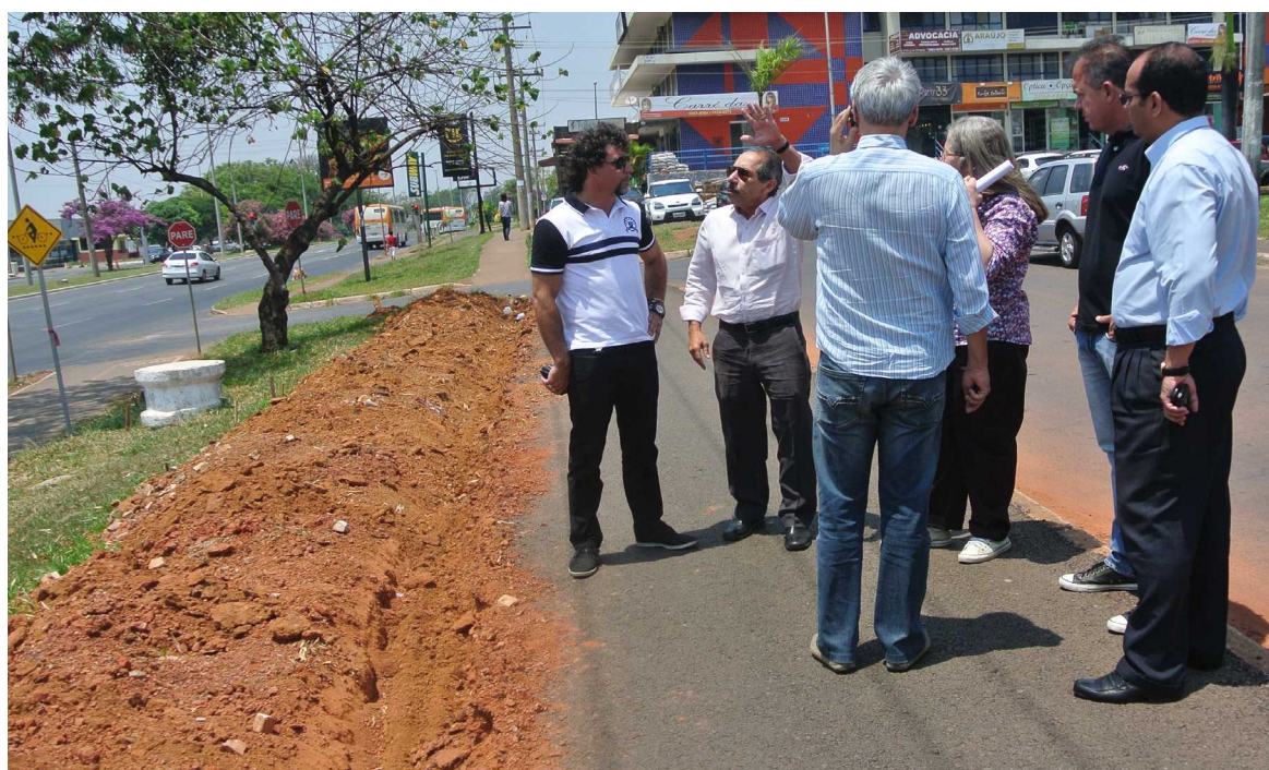
O novo administrador regional Wágner Sampaio (primeiro à esquerda, de camiseta) exigiu dos empreiteiros a entrega da obra no prazo previsto, dia 25 de novembro
