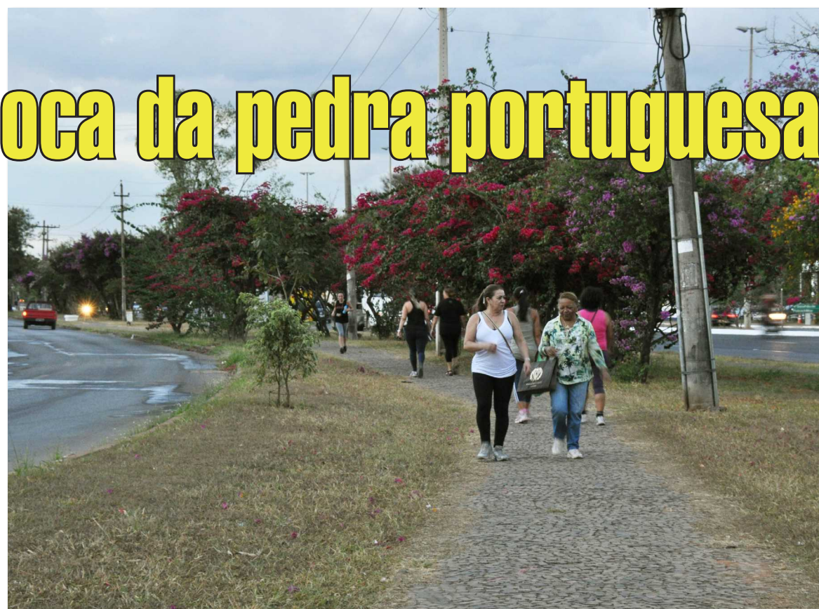
A pista de pedras portuguesas foi construída em 1986, inspirada no calçadão de Copacabana, no Rio de Janeiro. A fixação errada das pedras e a falta de manutenção acabaram por degradar todo o percurso, que também sofre com a passagem de carros e caminhões em alguns trechos.
