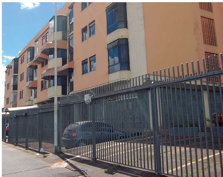
As grades em torno dos prédios do Guar4 I e Lúcio Costa, construídas para proteger os carros dos moradores poderão ser regularizadas com a aprovação da Luos, e precisam apenas cumprir os parâmetros de acessibilidade e afastamento previstos.
