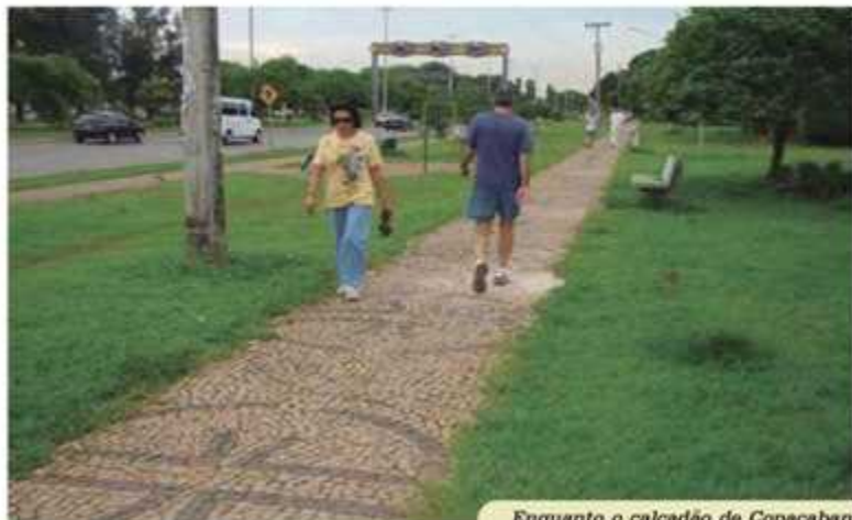
Enquanto o calçadão de Copacabana (direita) foi construído sobre massa de cimento, o do Guará foi montado sobre areia
