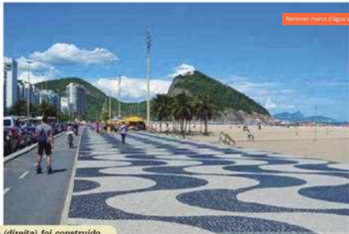
Enquanto o calçadão de Copacabana (direita) foi construído sobre massa de cimento, o do Guará foi montado sobre areia
