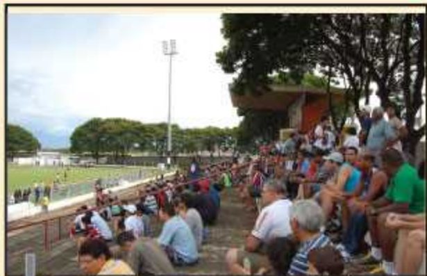
Se não for reformado para servir de centro de treinamento da Copa do Mundo pode ser interditado no próximo ano
