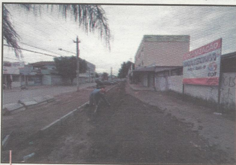
Construção de estacionamento na QE 4 do Guará I é uma das obras do pacote
