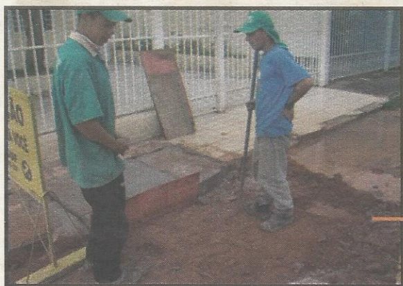
Equipes da Administração controem bocas de lobo onde há focos de alagamento
