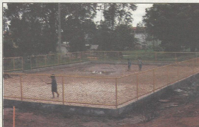
Campo de areia sem condições de uso
