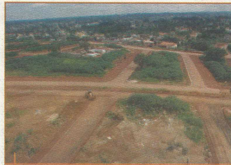
Área já está com a infraestrutura pronta, contratada pela Terracap
