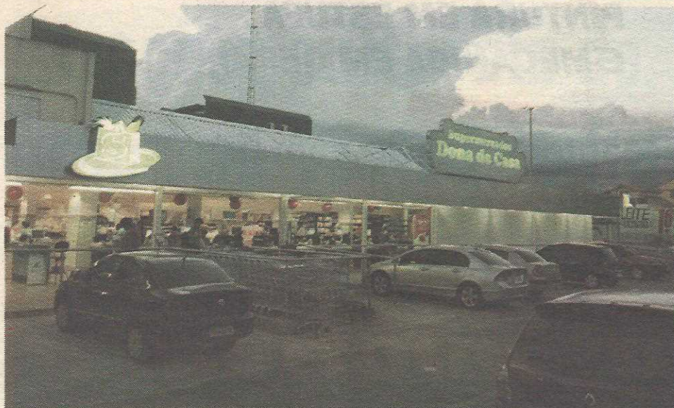
Reforma incluiu fachada externa
