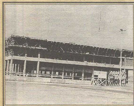
Construção do edifício Consei
