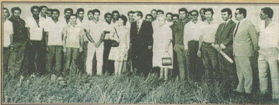
O prefeito de Brasília, Plínio Cantanhede (ao centro, de terno preto), acompanha um grupo de servidores da Novacap ao local onde seria o mutirão. O engenheiro Eduardo Mundim Pena (à direita, de terno), com o projeto da Vila Guarã em mãos
