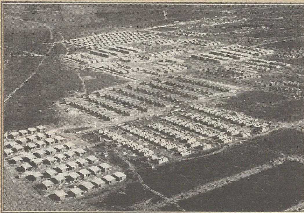
As primeiras casas construídas na QI-03 em regime de mutirão
