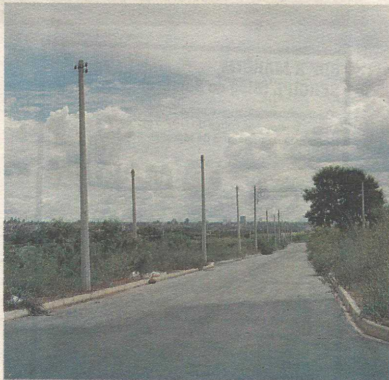
Toda a infraestrutura está pronta, mas o mato toma conta do local
