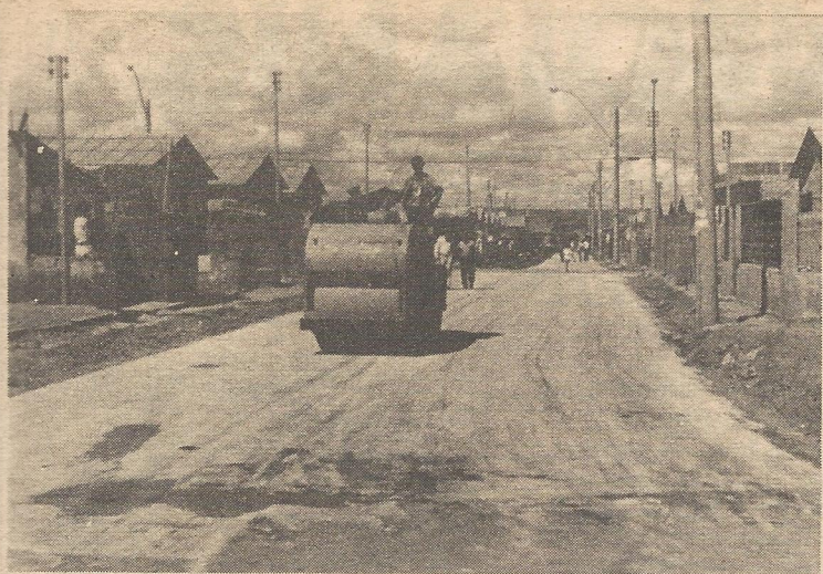
Asfaltamento da QE 38
