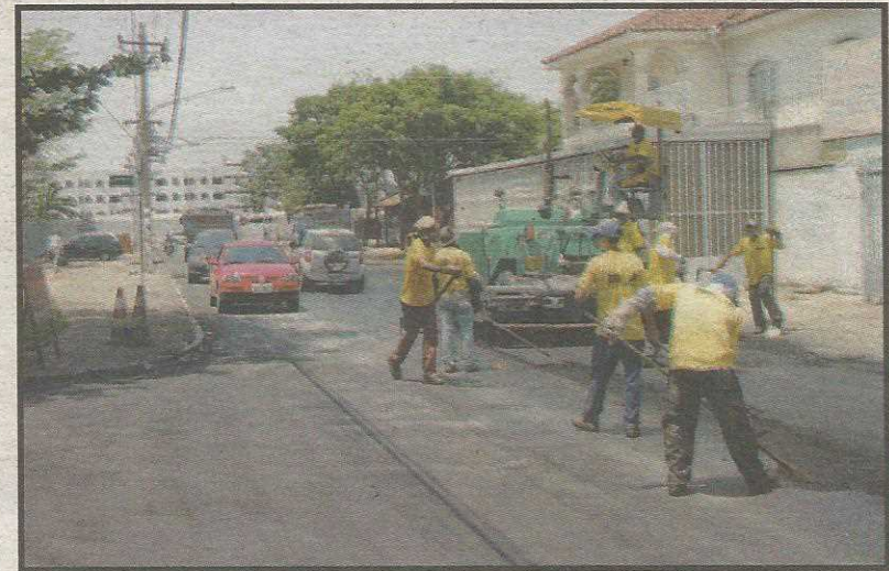
Obras são intensificadas antes das chuvas
