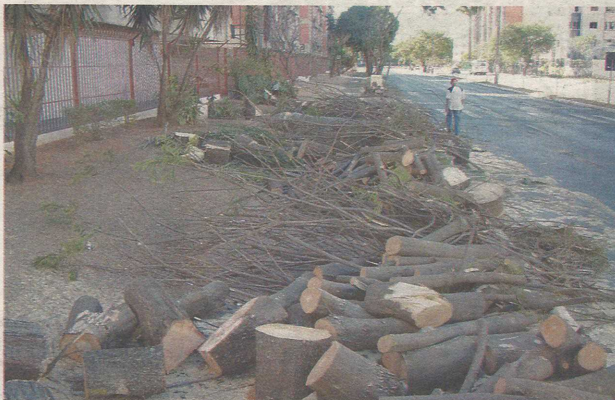
Árvores que comprometiam segurança dos prédios e da rede elétrica foram cortadas na QI 25
