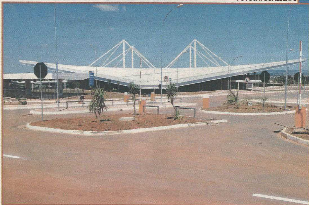
As obras estão quase concluídas. Terminal será o mais moderno do País
