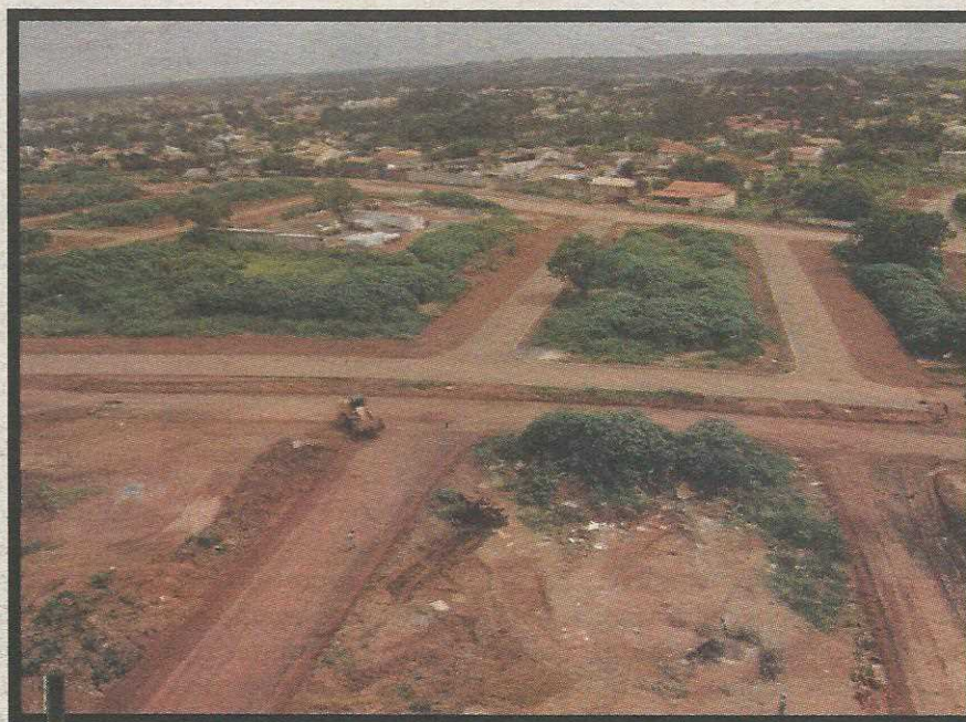
Infraestrutura está quase pronta para receber novos moradores
