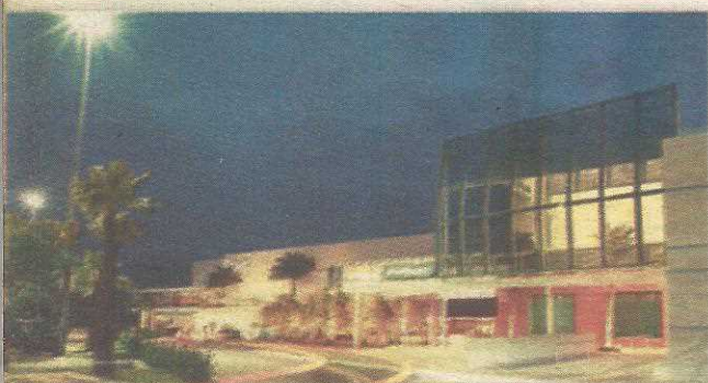
Fachada lateral da nova expansão
