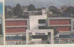
P6 - COLÉGIO PROJEÇÃO UNIDADE GUARÁ
