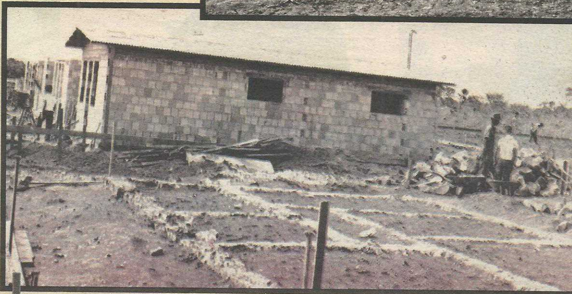
Na foto acima, topógrafos fazem as primeiras demarcações. E as primeiras casas em construção na QE 5
