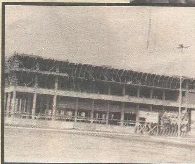
Construção do edifício Consei
