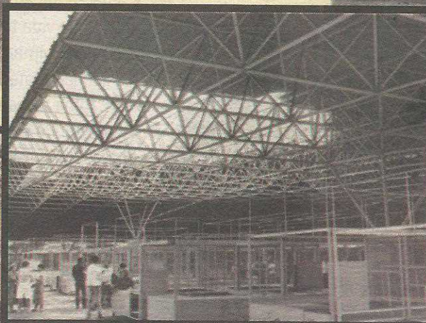
Construção da Feira do Guará
