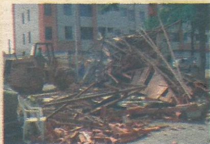
Quiosque da droga é demolido na QI 2
