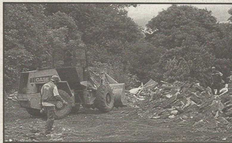
Para cumprir a TAC, demolições vão continuar
