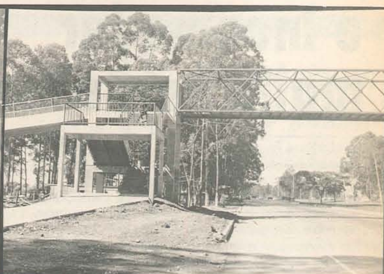
A passarela da EPTG
