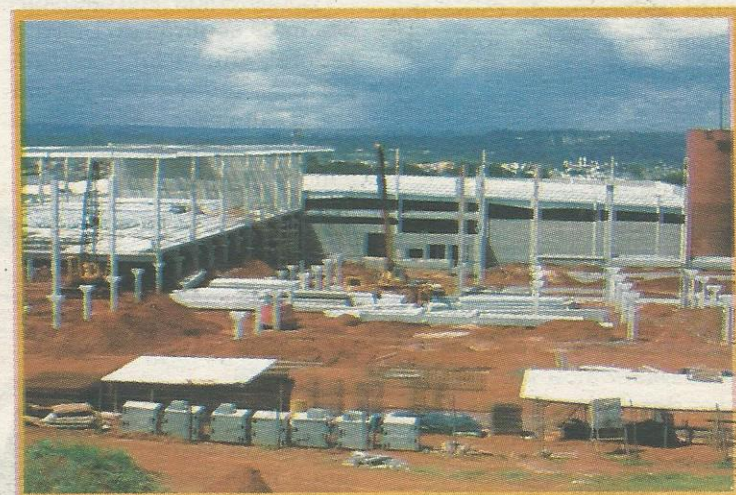
Obra do megacenter está em ritmo acelerado
