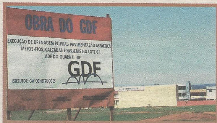
Pólo de Moda vai ganhar pavimentação e águas pluviais
