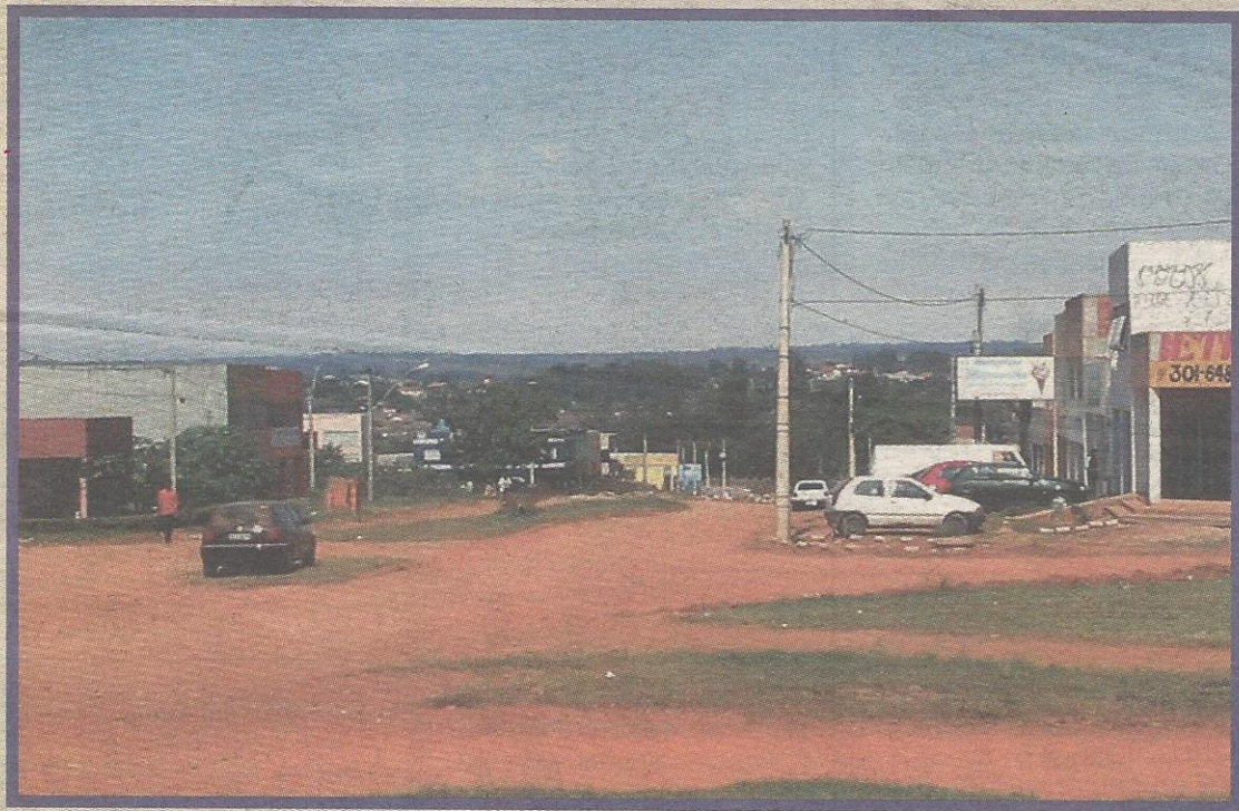
O Pólo de Moda vai ganhar pavimentação e rede de águas pluviais
