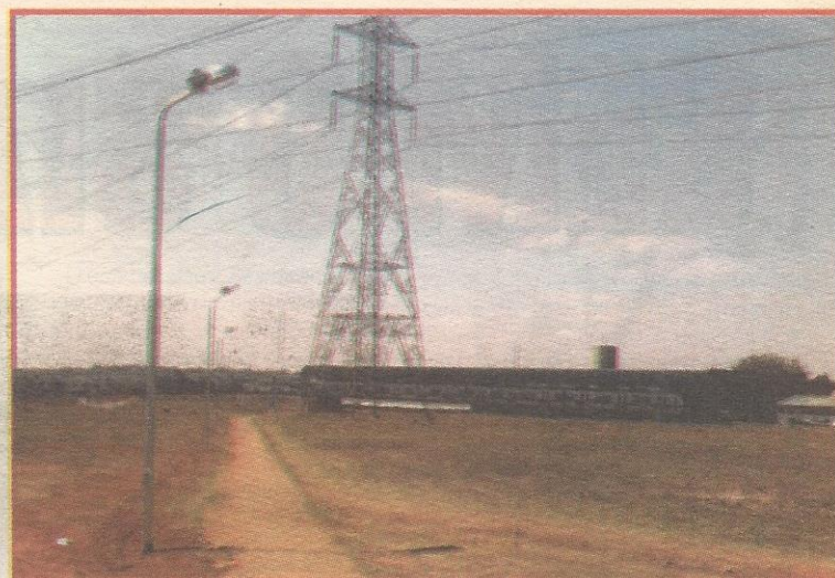
As passagens de pedestres entre o Guará I e o II foram iluminadas
