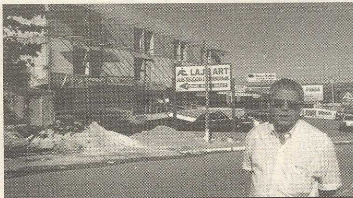
O empresário Lincoln Mesquita é um dos beneficiados, porque está com um edifício em construção na área
