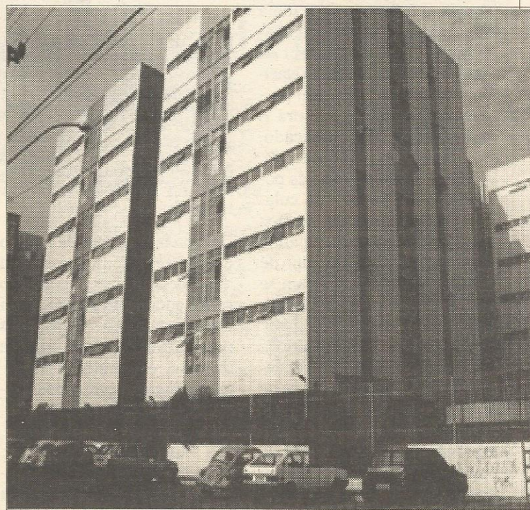
Edifício foi reformado, mas ainda apresenta sinais de rachaduras
