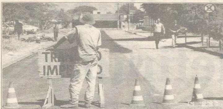
Todo o Guará I está sendo recapeado
