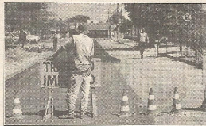
Via Central do Guará está sendo recapeada
