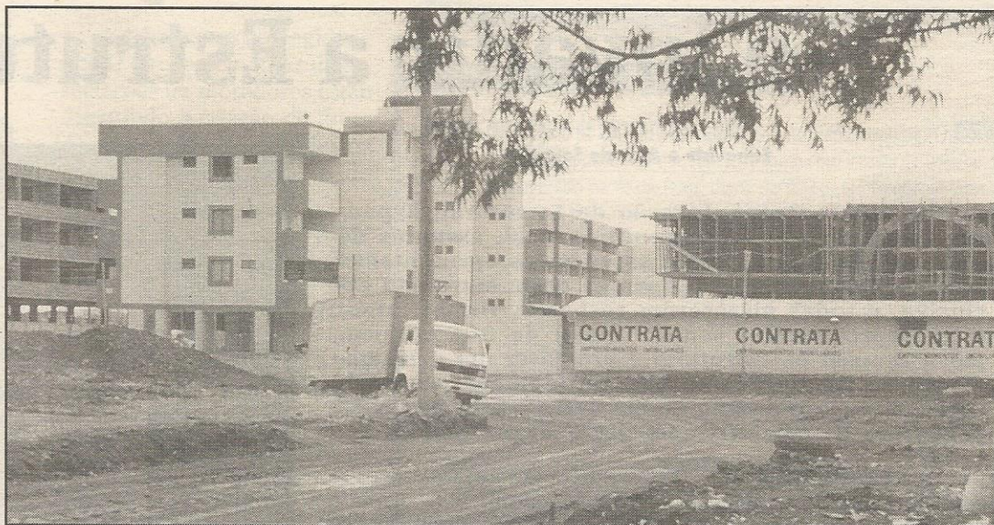
A quadra Lúcio Costa começa a receber obras de infra-estrutura
