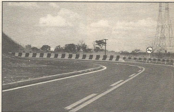
Nova pista facilita acesso Terminal de Cargas à Estrutural
