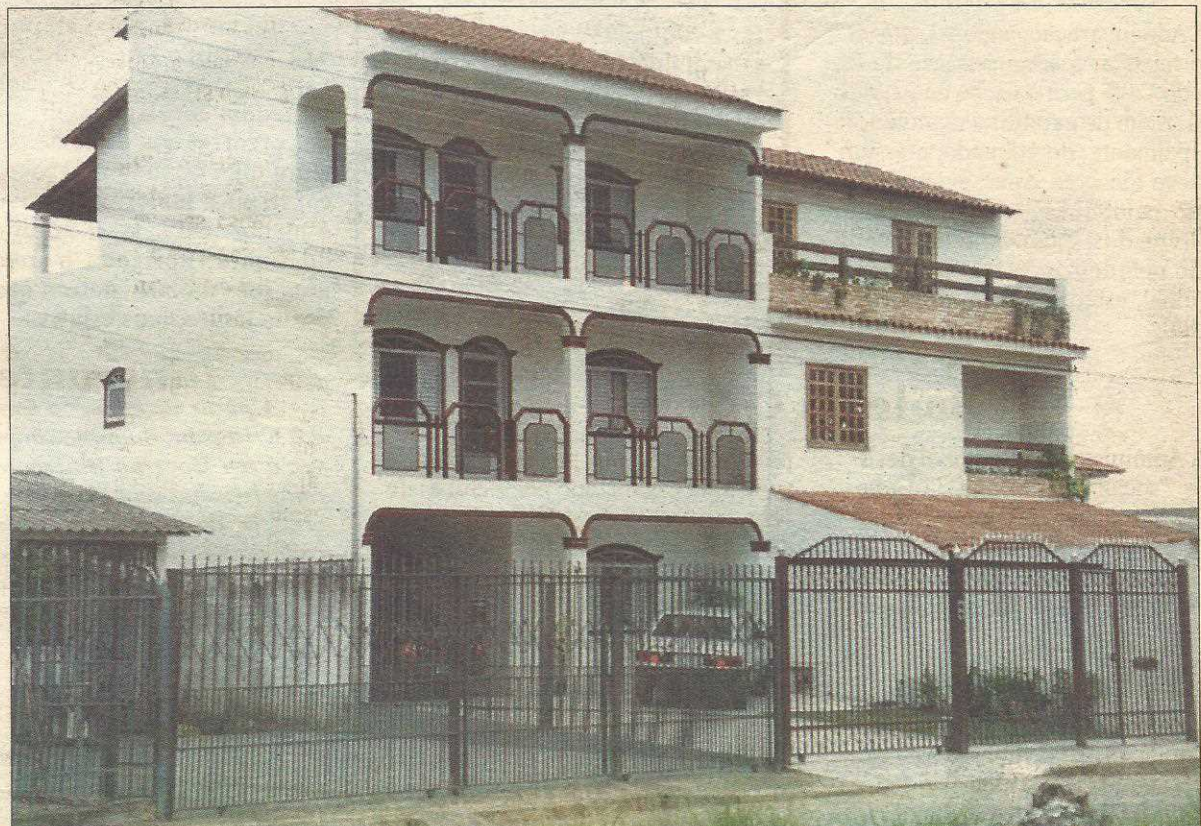
O projeto regulariza uma situação que toma conta da cidade: a construção de todo o terceiro pavimento nas casas do Guará e Núcleo Bandeirante.
