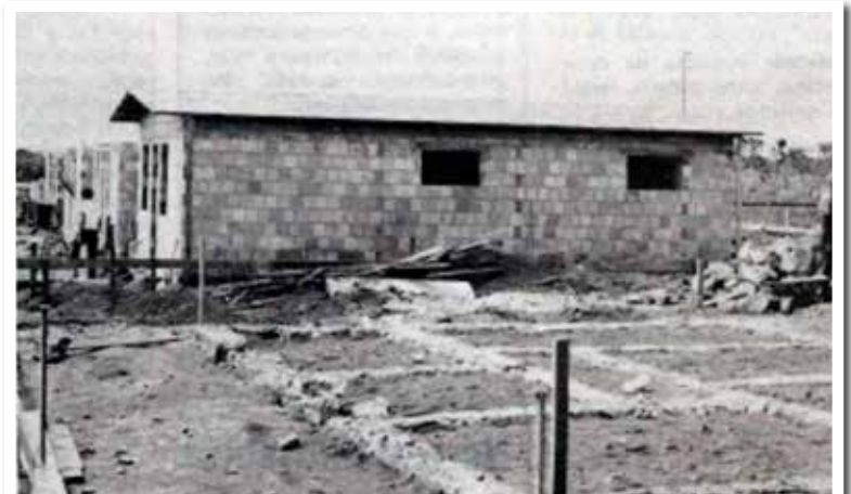
à construção da primeira casa...
