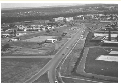
Em 1968, a SHIS, com recursos do Banco Nacional de Habitação (BNH) começou a construção dos edifícios residenciais
