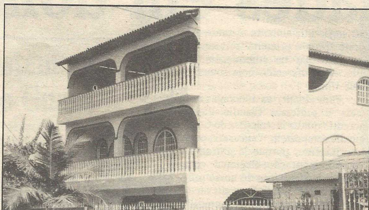
Os novos sobrados já estão sendo construídos com o terceiro pavimento total
