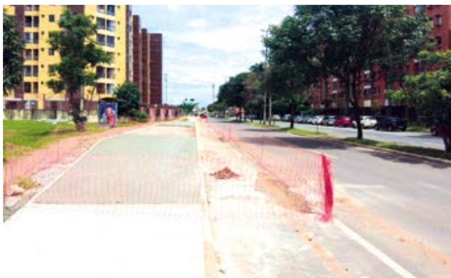
Primeira etapa da obra deve ficar pronta nos próximos dias. O trecho entre a delegadia e o Ed. Consei será o próximo
