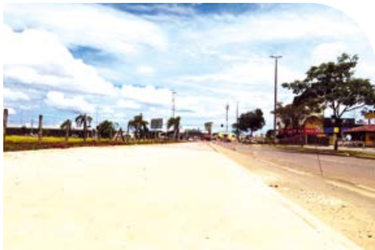
Em alguns pontos as calçadas e a ciclovia tem mais de 3 metros de largura
