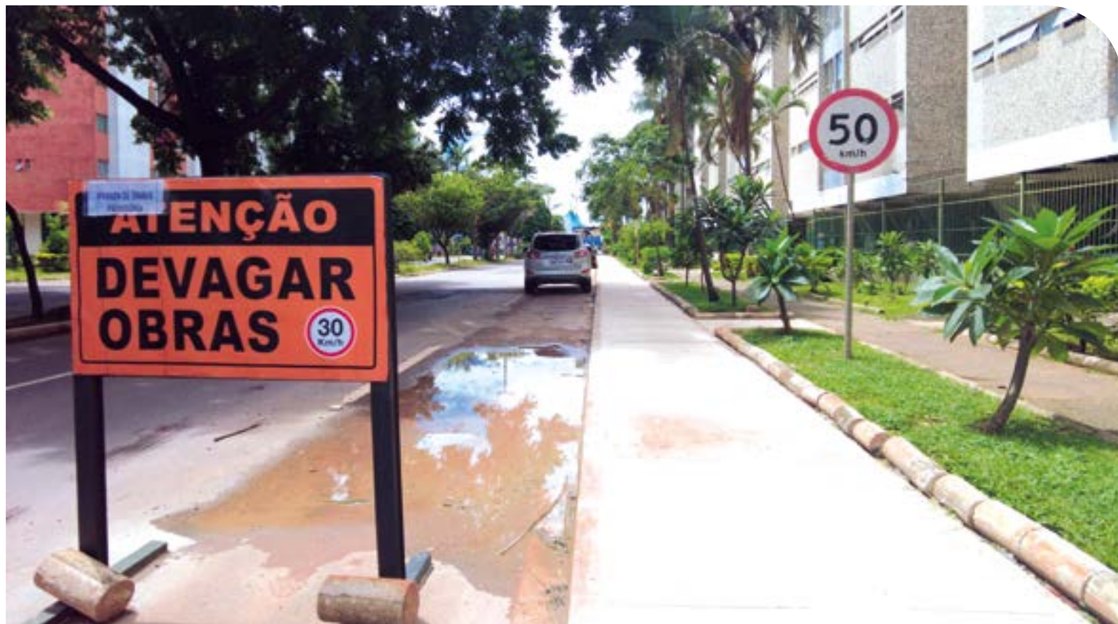
O trecho na QI 23 está quase pronto. Ali, uma ciclovia foi construída ao lado da calçada já existente. O restante da pista suprimida virou estacionamento. As duas outras pistas continuam livres para os carros
