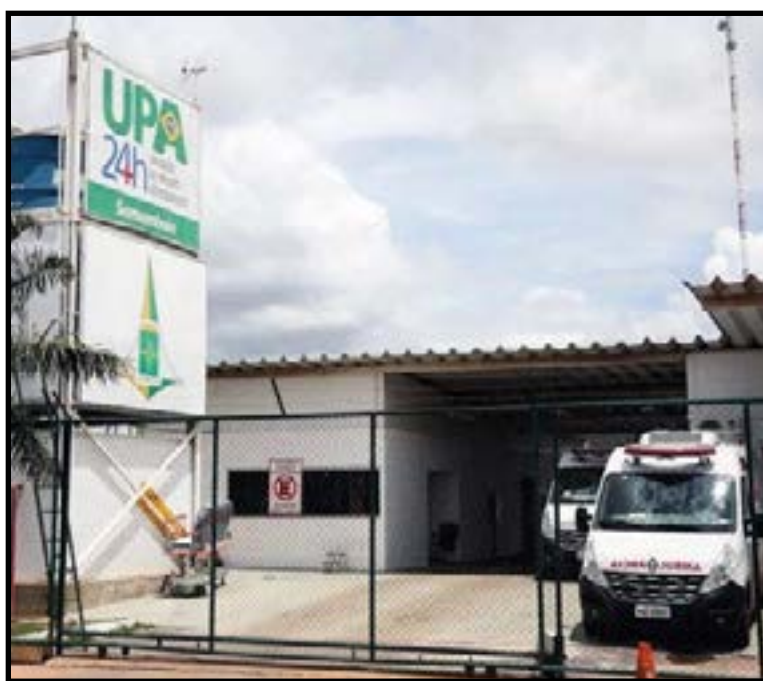
UPA será instalada na QI 23 do Guarú II
