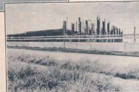
Comunal I, em construção
